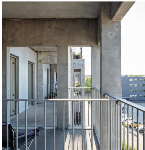
Рис. 1.3. Вигляд зсередини на прибудовані тераси (фото: Adam Khan Architects, https://adamkhan.co.uk/projects/ellebo-garden-room/ )
