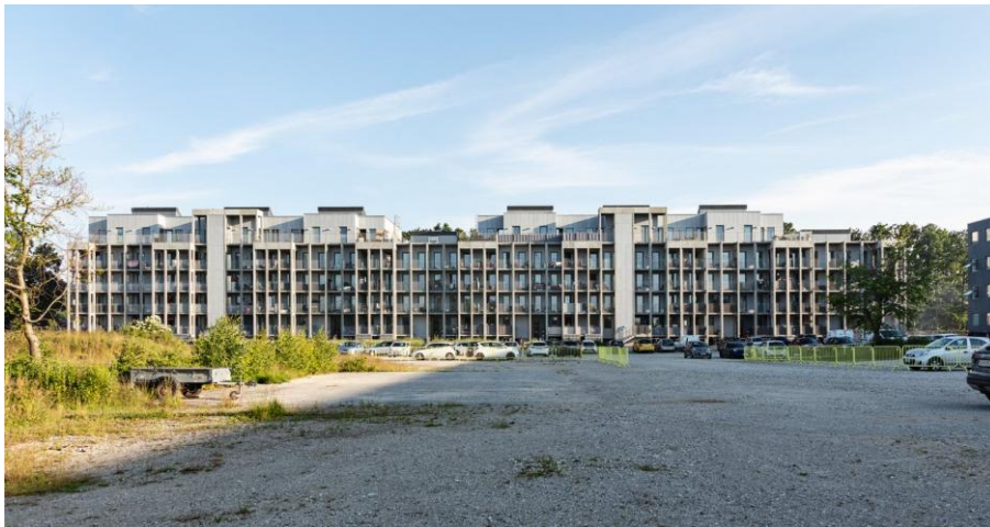
Рис 1.1. Зображення оновленого вигляду будинку (фото: Adam Khan Architects, https://adamkhan.co.uk/projects/ellebo-garden-room/ )
